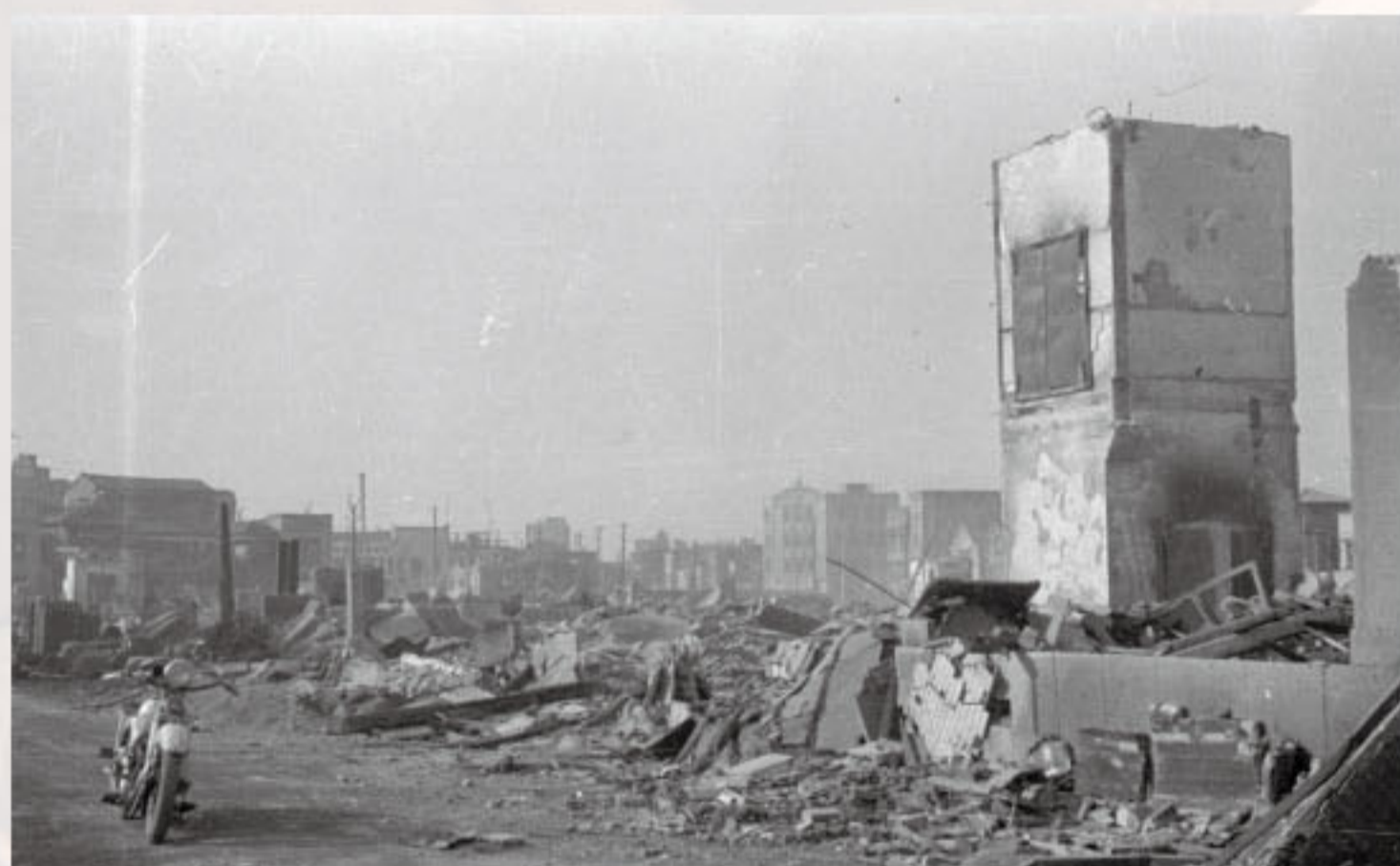
日本橋区小網町の焼跡 1945年3月11日、石川光陽撮影
